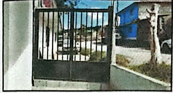
Foto 8: Instalación de portón de metal en la entrada principal del establecimiento
