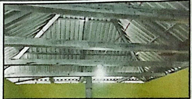
Foto 2: Instalacion o sustrucion de focos de cocina
