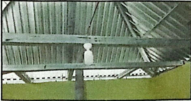
Foto 1: Sustrucion de estructura de soporte de madera por metal de cocina
