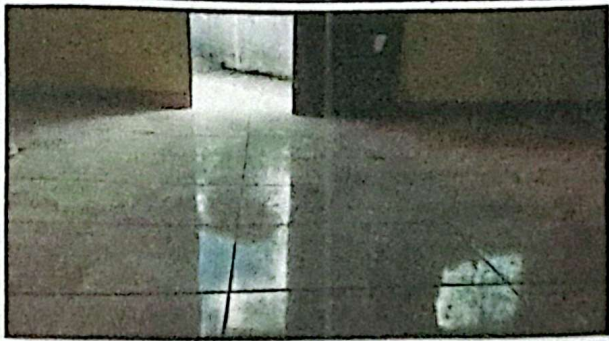
Foto 7: Sustrucción de piso de torta de concreto por piso cerámico de cocina
