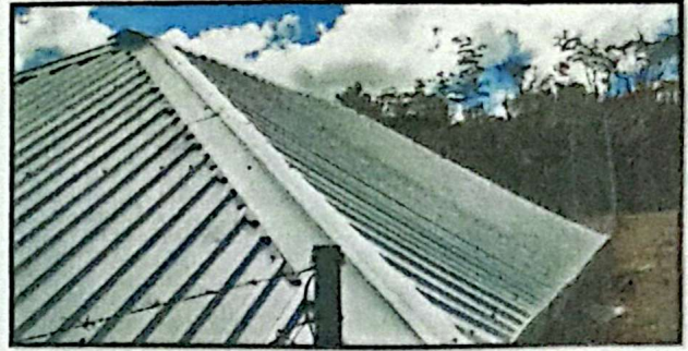
Foto 4: Sustrucion de lamina por lamina troquelada aluzinc calibre 26 de cocina
